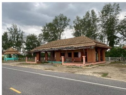
ภาพที่ 6 สิ่งปลูกสร้างที่ได้รับความเสียหายจากการกัดเซาะชายฝั่งและลมมรสุม บริเวณหมู่ที่ 2 ตำบลสิงโค อำเภอสิงหนคร จังหวัดสงขลา
