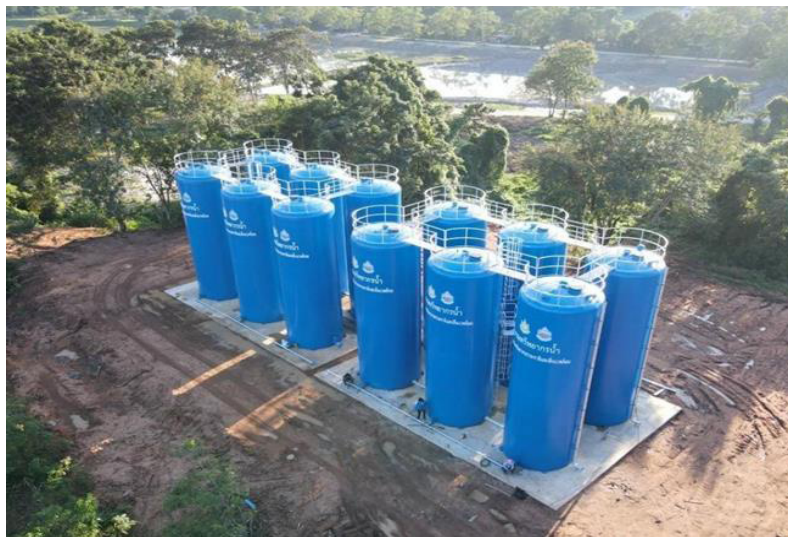
ภาพที่ 2 แสดงจุดก่อสร้างถังเก็บน้ำ FIBER GLASS ขนาดความจุ 100,000 ลิตร จำนวน 12 ถัง บริเวณด้านข้างหอประชุมใหญ่ มหาวิทยาลัยราชภัฏเชียงราย ที่มา : (สำนักงานทรัพยากรน้ำที่ 1, 2565)
