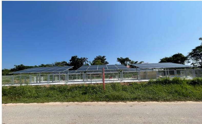
ภาพที่ 1 แสดงจุดก่อสร้างระบบกระจายน้ำด้วยพลังงานแสงอาทิตย์ ขนาด 11 กิโลวัตต์ แบบเสริมประสิทธิภาพ บริเวณข้างหนองบัว ด้านหลังหอประชุมใหญ่ มหาวิทยาลัยราชภัฏเชียงราย ที่มา : (สำนักงานทรัพยากรน้ำที่ 1, 2565)
