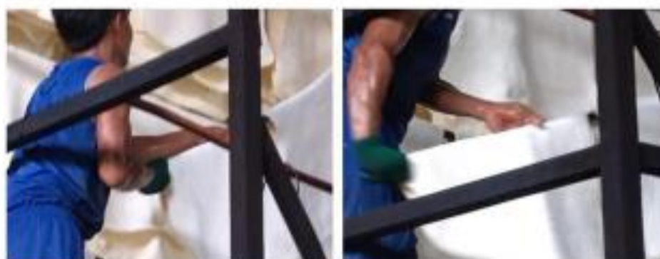
รูปที่ 17 ลำเลียงยางขึ้นบน (ขั้นตอนที่ 3)
