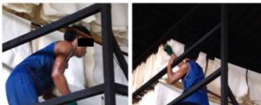
รูปที่ 19 ลำเลียงยางขึ้นบน (ขั้นตอนที่ 9)
