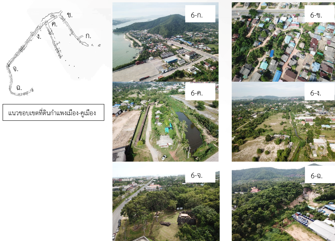
รูปที่ 6 การสำรวจในภูมิประเทศของรอบกำแพงเมือง-คูเมืองสงขลา (สิงหนคร) ก.แนวคูเมืองติดชายฝั่งทะเลอ่าวไทย ข.แนวคลองระบายบริเวณด้านทิศเหนือของเมือง ค.แนวคูเมือง-กำแพงเมืองทิศตะวันออกเฉียงเหนือของเมือง ง.สภาพคูเมืองทางทิศตะวันตกเฉียงเหนือ จ.คูเมืองหน้าป้อมปืนหมายเลข 9 ฉ.บริเวณมุมเมืองทิศตะวันตกเฉียงเหนือ ที่มา : ถ่ายโดย คณะผู้วิจัย
