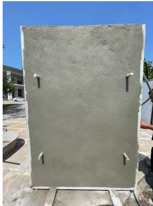
รูปที่ 2 การติดตั้ง/การสร้างผนังคอนกรีตที่มีชุดระบายความร้อนอยู่ด้านใน
