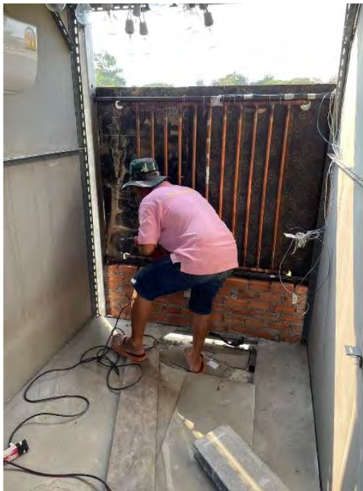
รูปที่ 2 การติดตั้ง/การสร้างผนังคอนกรีตที่มีชุดระบายความร้อนอยู่ด้านใน
