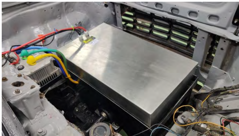
รูปที่ 7 แสดงการติดตั้งแบตเตอรี่รถยนต์ไฟฟ้า
