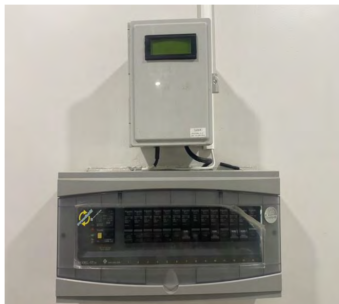
รูปที่ 6 แสดงการติดตั้งอุปกรณ์ตรวจวัดและแจ้งเตือนการใช้พลังงานไฟฟ้าแบบสมาร์ทโฮมใช้งาน
