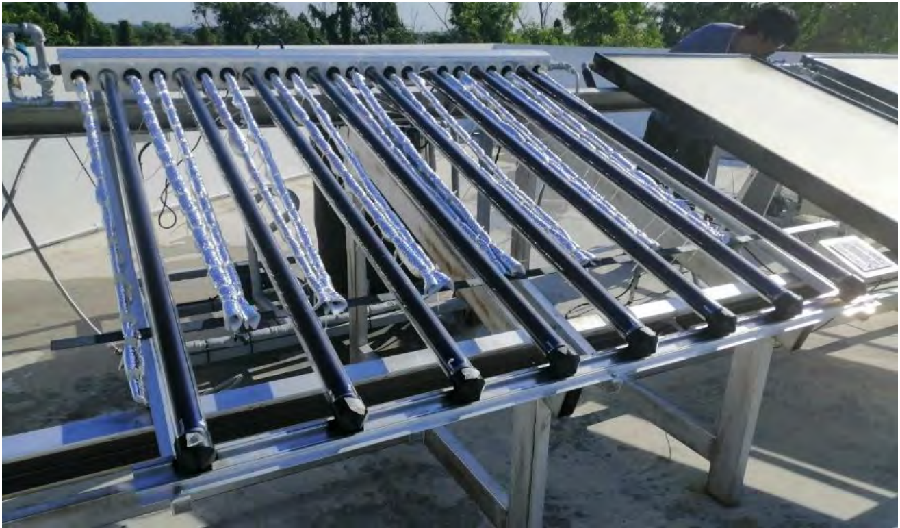
รูปที่ 2 ตัวเก็บรังสีอาทิตย์แบบหลอดแก้วสุญญากาศชนิดท่อความร้อน
