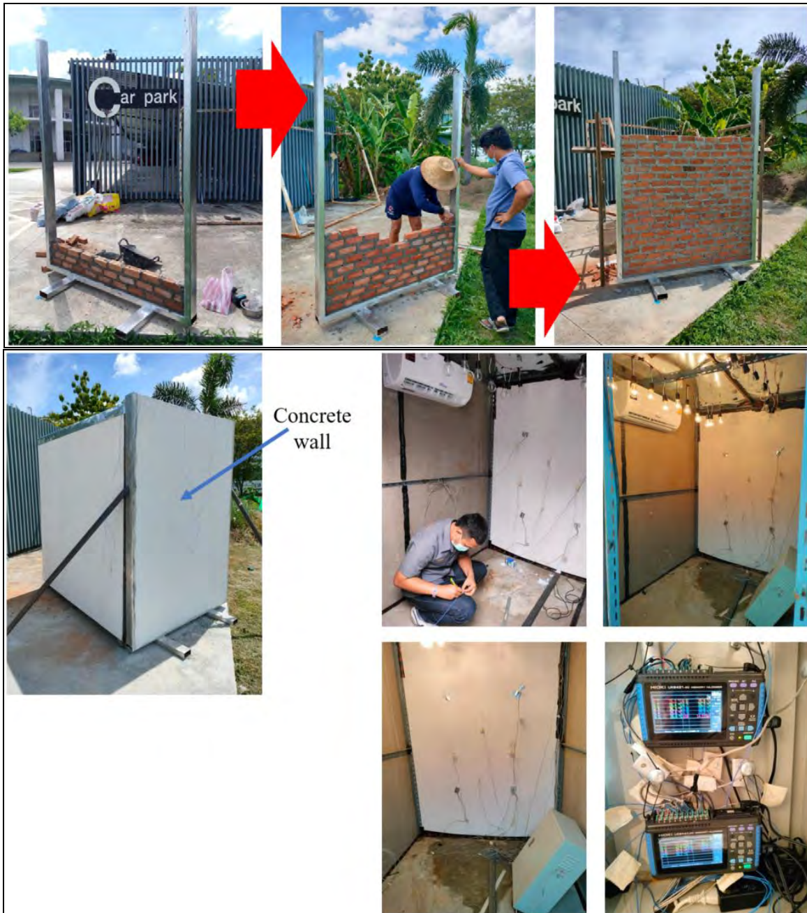
รูปที่ 3 ผนังคอนกรีตที่ได้ดำเนินการก่อสร้าง และตัวอย่างการติดตั้งเครื่องมือวัดอุณหภูมิของผนัง
